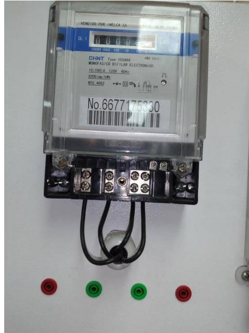
FIGURA 6 CONTADOR MONOFASICO EXSITENTE EN EL LABORTORIO
