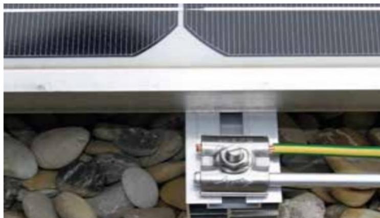
Placa intermedia de acero inoxidable que evita la corrosión por contacto, estableciendo conexiones fiables a largo plazo entre los diferentes materiales conductores
