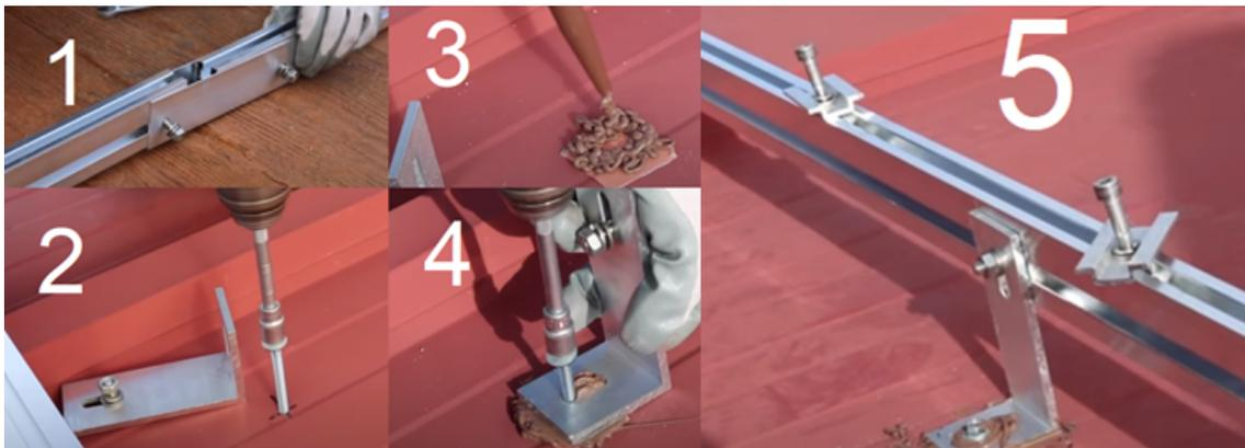
**Figura 27. Pasos Para la Instalación de la Estructura – Soporte en Cubierta. Fuente: Autosolar**
