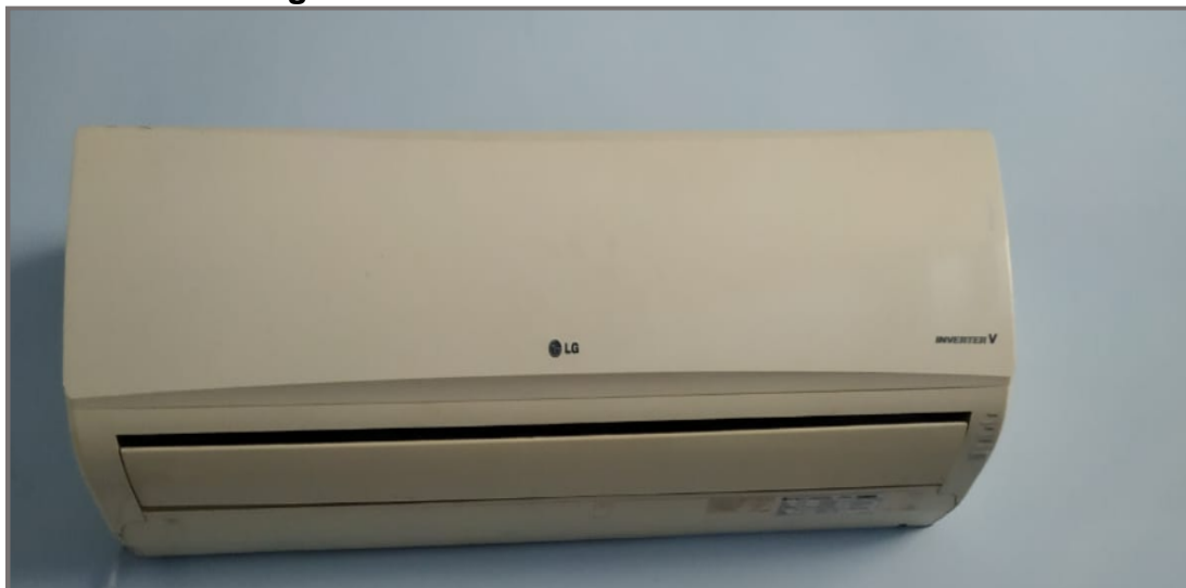
Figura 7. Aire con condición de 12000 btu/h
