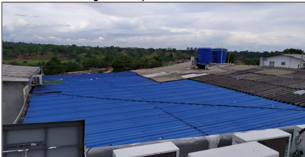
Figura 12. Tejado termo acústico
