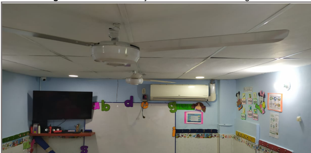
Figura 10. Ventiladores y televisión de Liceo Amiguitos
