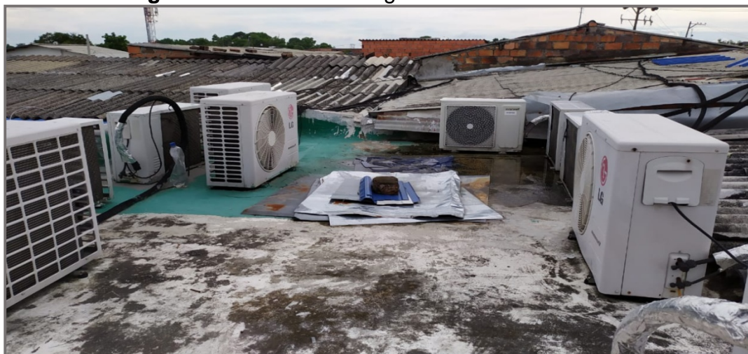
Figura 8. Sistema de refrigeración de la institución
