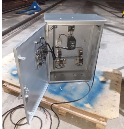
Figura 45. Vista general del tablero de control
