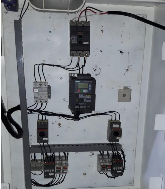
Figura 44. Cableado de componentes del tablero de control
