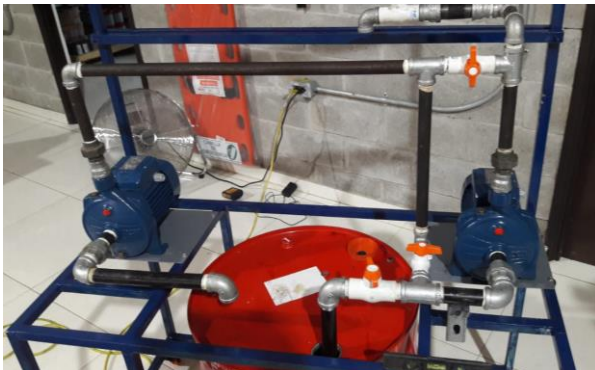
Figura 46. Ubicación de bombas y líneas de tubería
