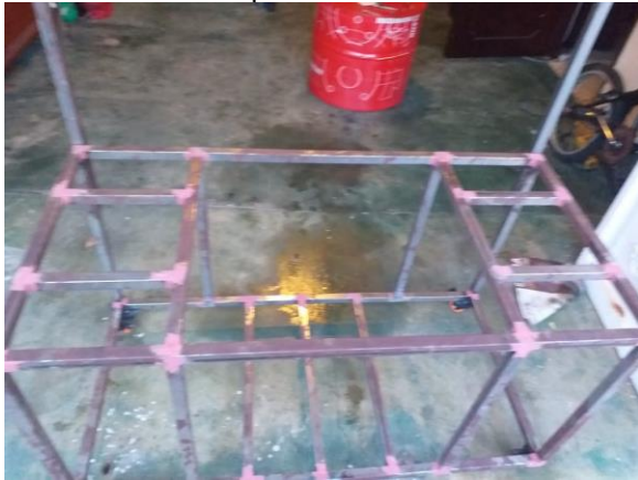
Figura 42. Armado de la estructura metálica mediante aplicación de soldadura
