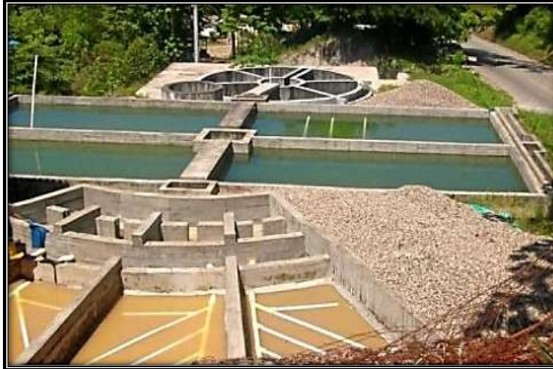
Figura 4. Acueducto del corregimiento de La Fortuna
