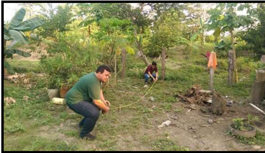
Figura 14. Medición de terreno en casa de Familia Castillo, Zarzal la Y
