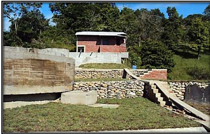
Figura 5. Construcción del acueducto de La Fortuna
