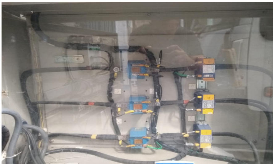
Figura 7. Selección de transformadores de corriente
