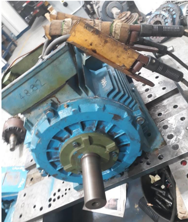
Figura 14. Inspección eléctrica al equipo Wester Electric
