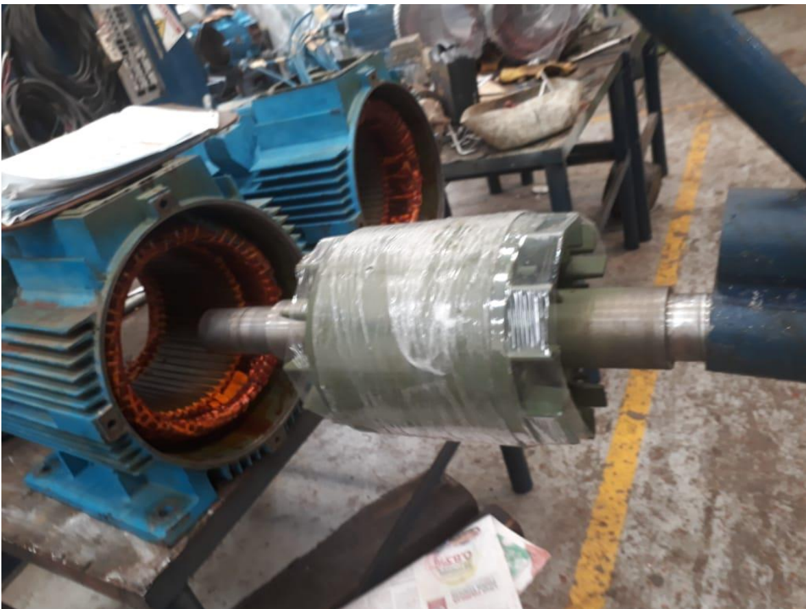
Figura 15. Ensamble de rotor al equipo Wester Electric
