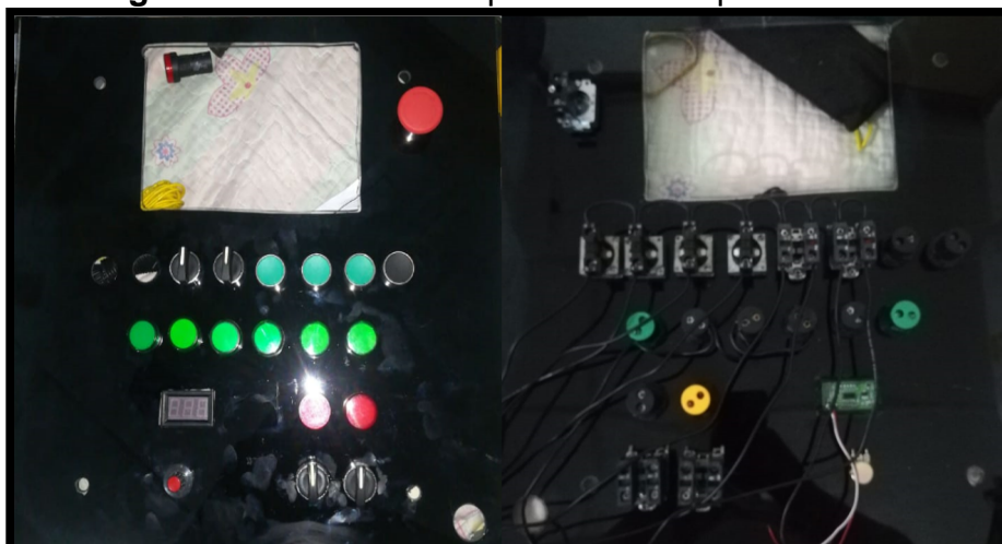
Figura 31. Instalación de pulsadores en panel frontal
