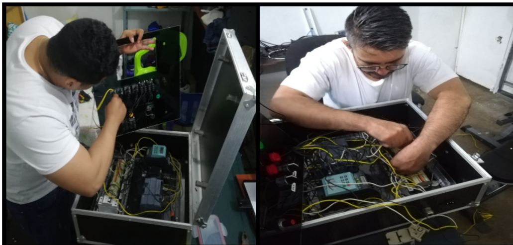
Figura 41. Conexionando panel frontal
