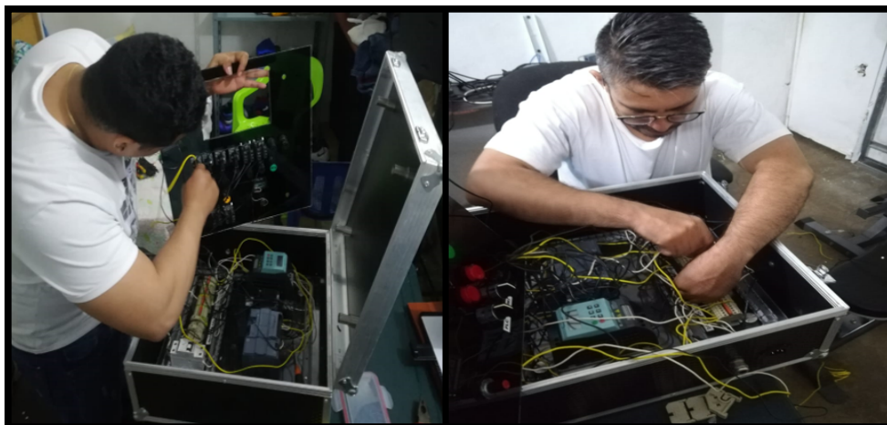
Figura 79. Conexionando panel frontal
