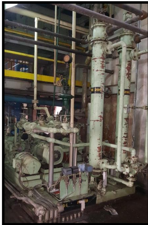
Figura 10: intercambiadores de calor
