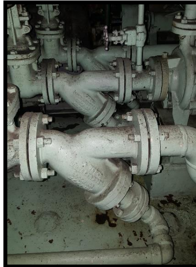
Figura 12: filtro de succión bombas auxiliares
