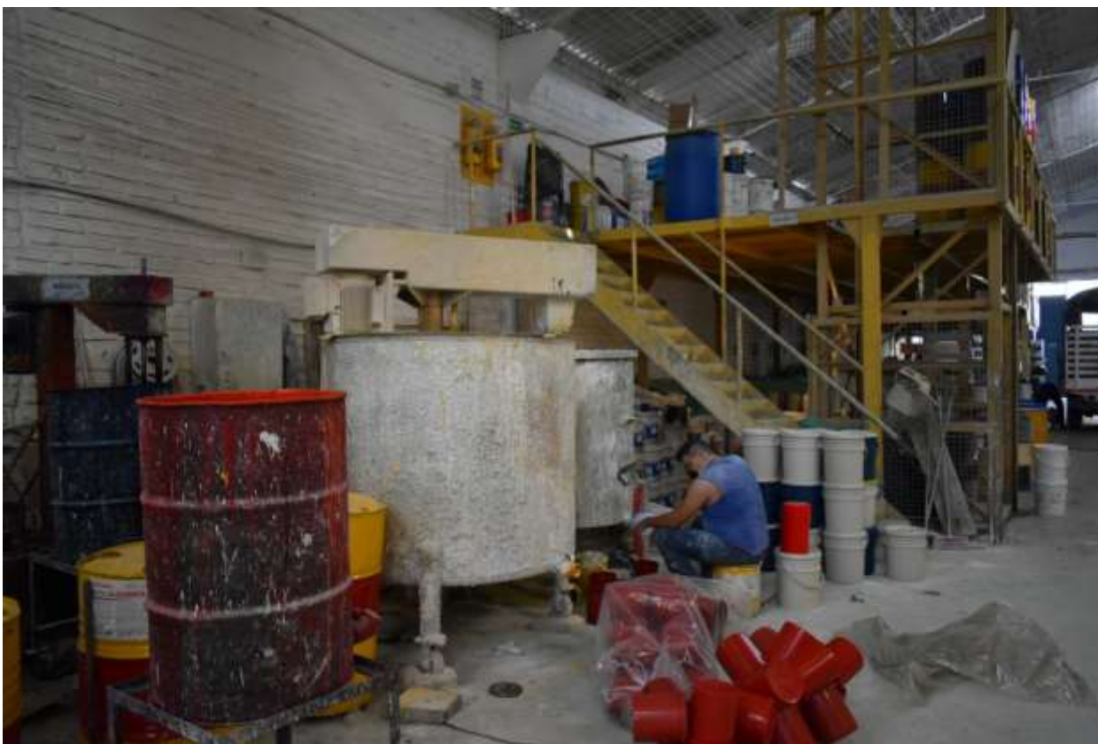
Figura 22. Tanques de preparación de pinturas
