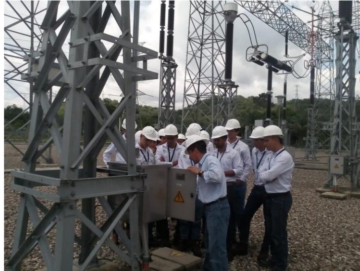
Imagen 2 Inspección de tablero de control en patio.
