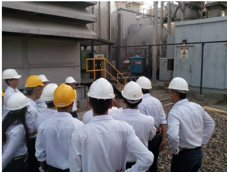
Imagen 3 Zona de excitación del generador.
