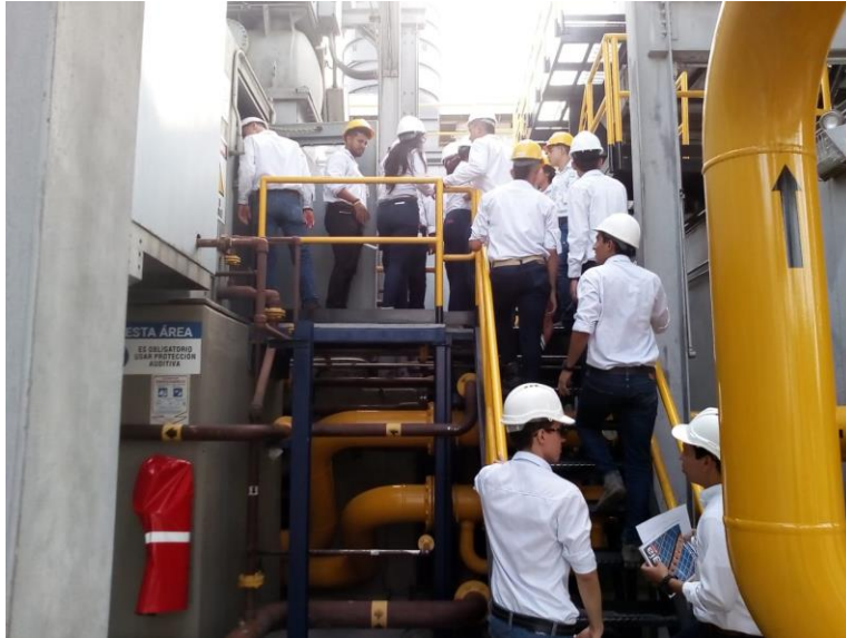
Imagen 2 Inspección de tablero de control en patio.
