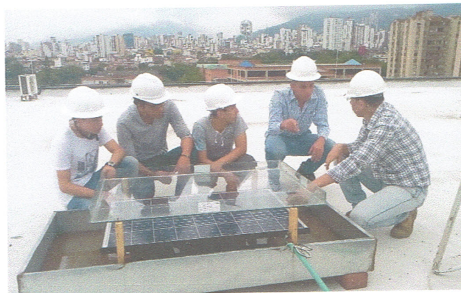
Figura 3 Instalación del panel fotovoltaico.
