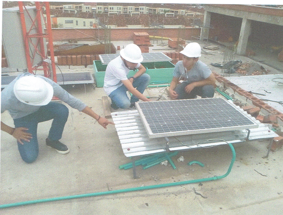
Figura 1 inspección de conexión de panel fotovoltaico.
