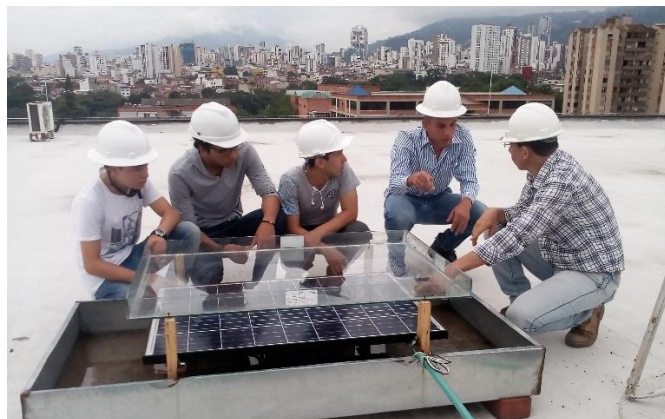
Figura 3 Instalación del panel fotovoltaico.
