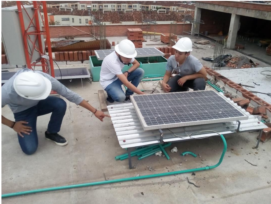
Figura 1 inspección de conexión de panel fotovoltaico.
