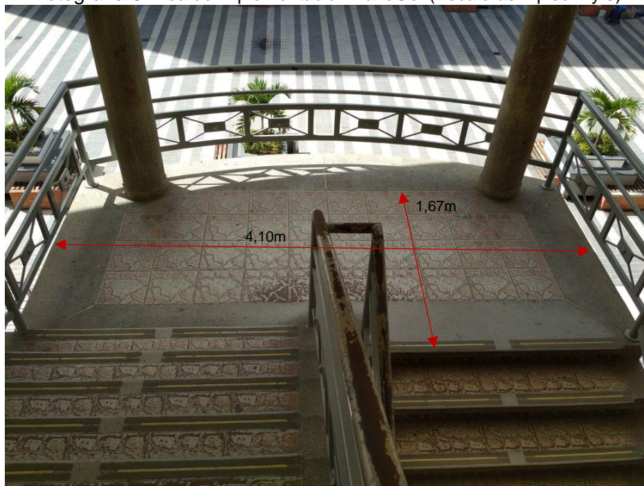
Fotografía 8 Área de implementación PaveGen(Escaleras 1 piso 2 y 3)
