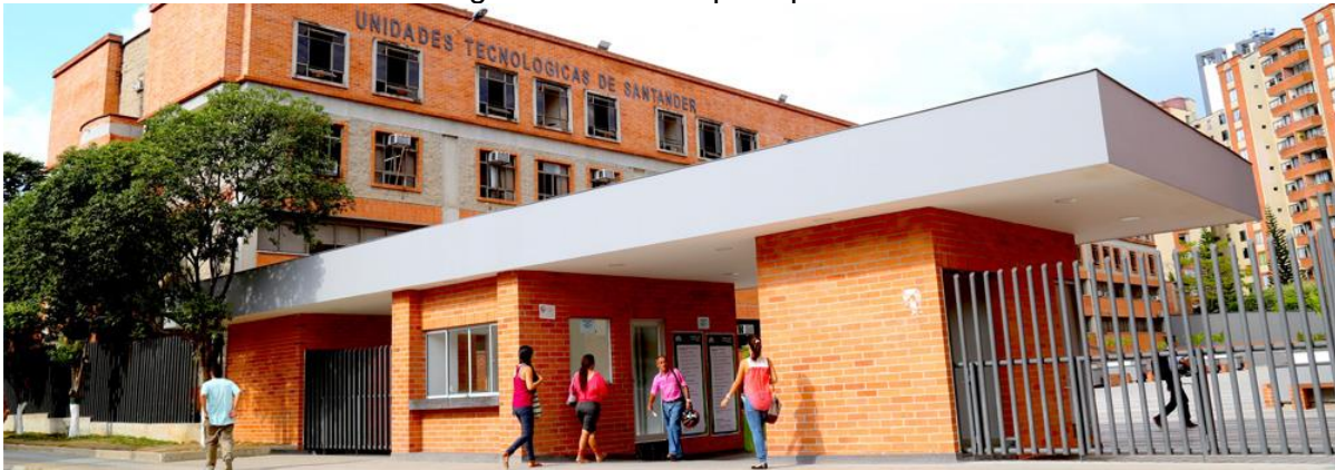
Fotografía 6 Entrada principal UTS.
