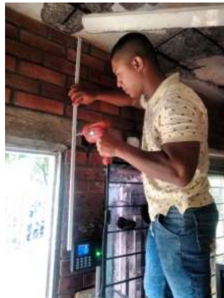
Figura 19: instalación de canaleta
