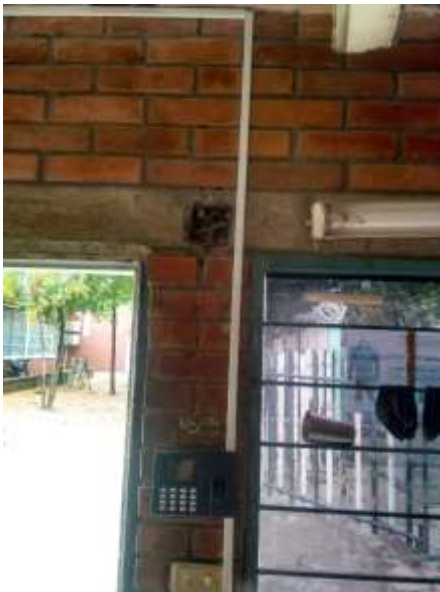
Figura 18 Biométrico instalado
