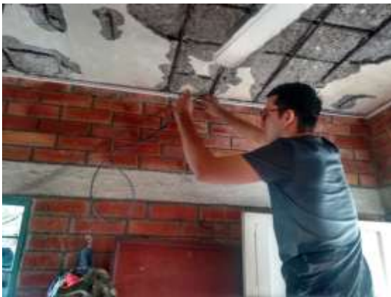
Figura 20: instalación cable de red
