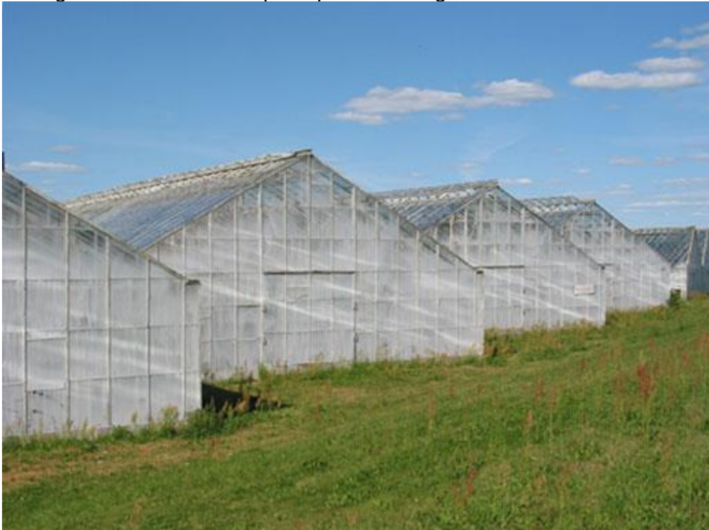
Figura 2. Invernadero tipo capilla a dos aguas con diente de sierra
