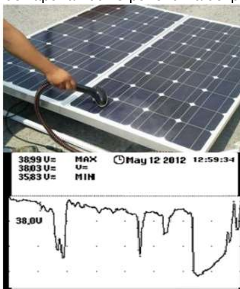
Figura 4. Condiciones de vapor a 100 °C por encima del panel solar fotovoltaico.
