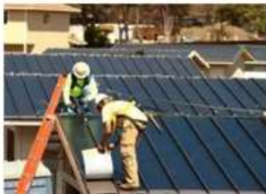
Figura 7. Fijación directa de módulos fotovoltaicos flexibles a techo.
