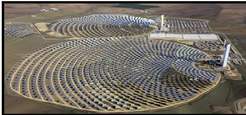
Figura B. Campo de heliostatos norte.
