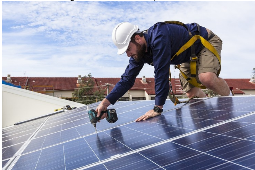
Figura 9: Instalación de panel solar
