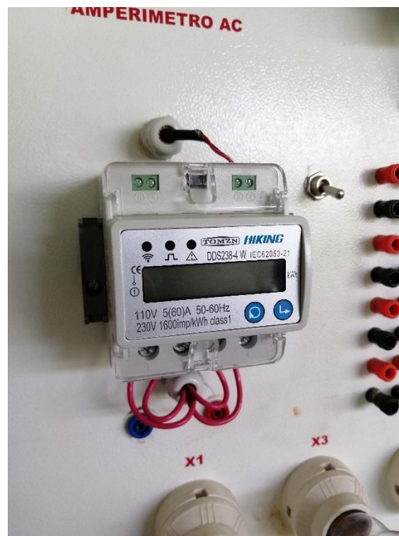
Figura 21. Instalacion completa del medidor DDS-4W
