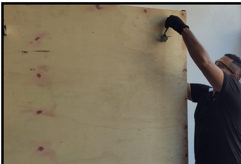
Figura 24. Instalación de soportes
