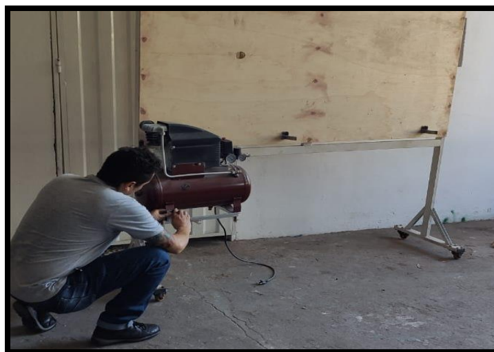
Figura 27. Instalación de compresor
