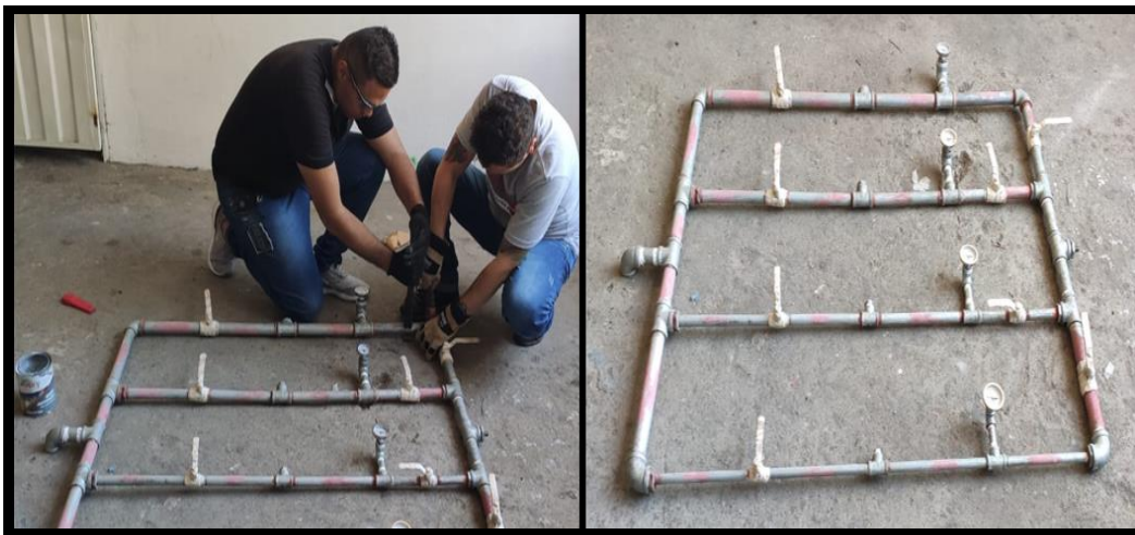
Figura 23. Ensamble de accesorios y tubería
