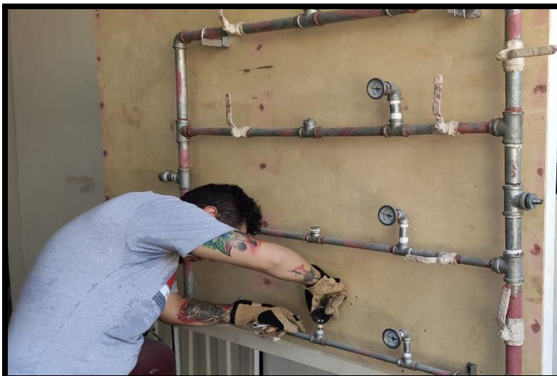
Figura 26. Instalación de indicadores de presión y temperatura
