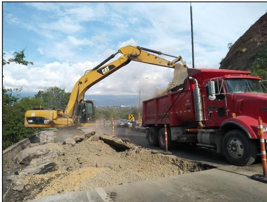
**Imagen 22.** Maquinaria de la obra: Retroexcavadora
