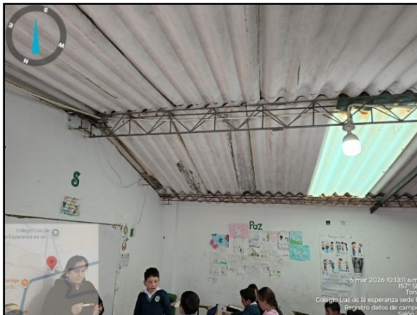
Figura 27. Continuidad estructural del techo en acero
