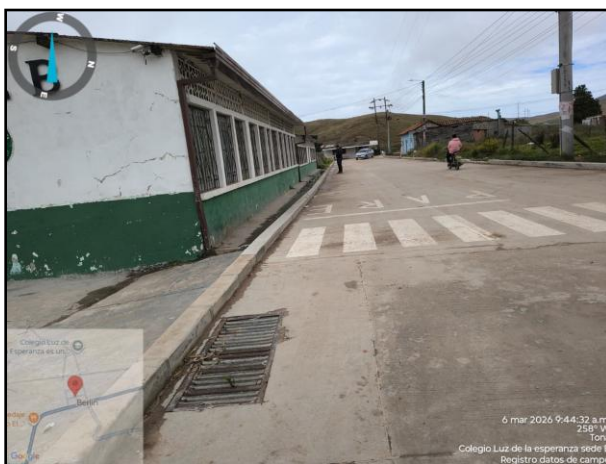
Figura 38. Falta de espacio público adecuado
