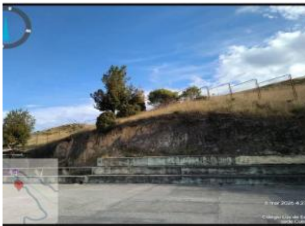
Figura 42. Talud vertical expuesto sobre el patio principal
