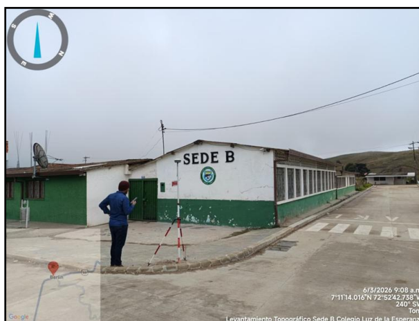
Figura 35. Diferencia de nivel entre la vía y el andén
