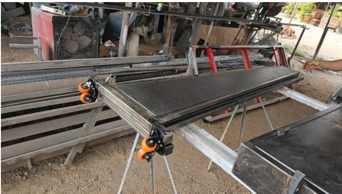
Figura 9. Construcción de la estructura física del banco de simulación. (A) Fabricación y ensamblaje de la estructura metálica. (B) Aplicación de acabados y preparación para la integración de dispositivos eléctricos y electrónicos.
