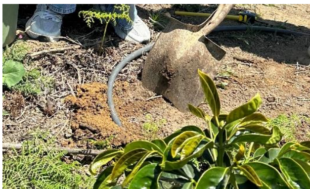
Figura 3. Retiro de capa vegetal
