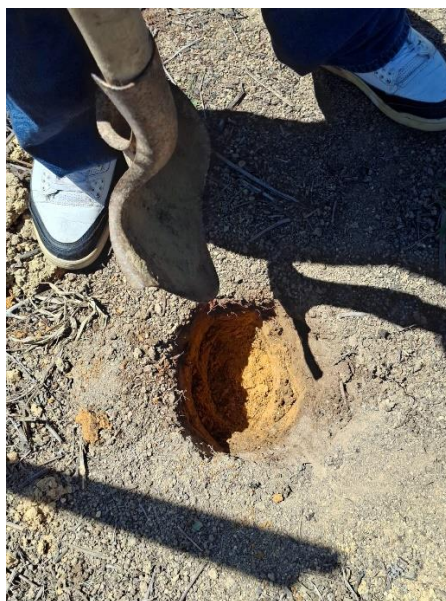
Figura 4 Excavación de 25cm
