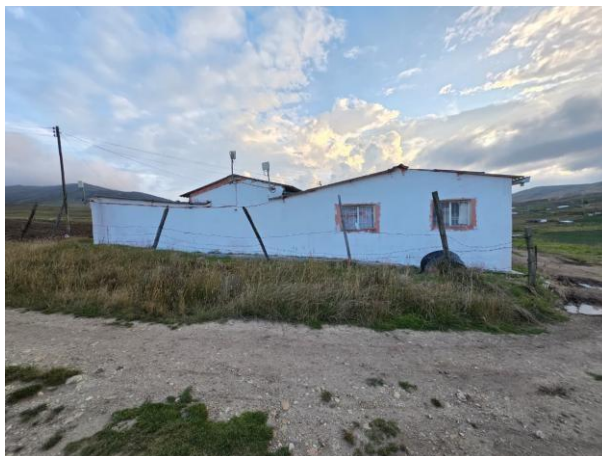
Figura 28. Delimitación precaria del área de la IE
