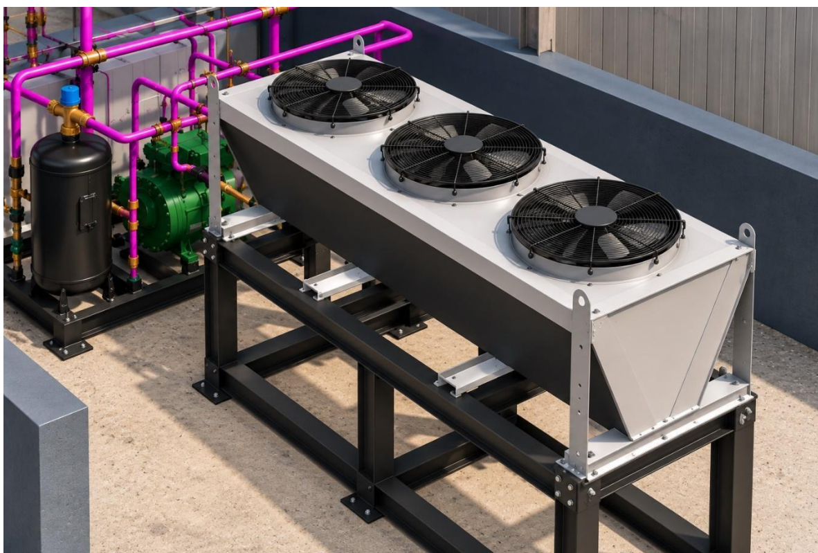
Figura 31. Renderizado del condensador y estructura de soporte.
