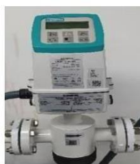
Figura 1. Medidor de caudal siemens MAG6000.
