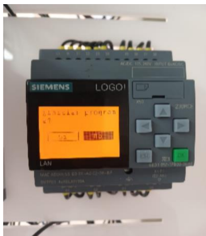
Figura 32 Montaje logo V8 en tablero proyecto
