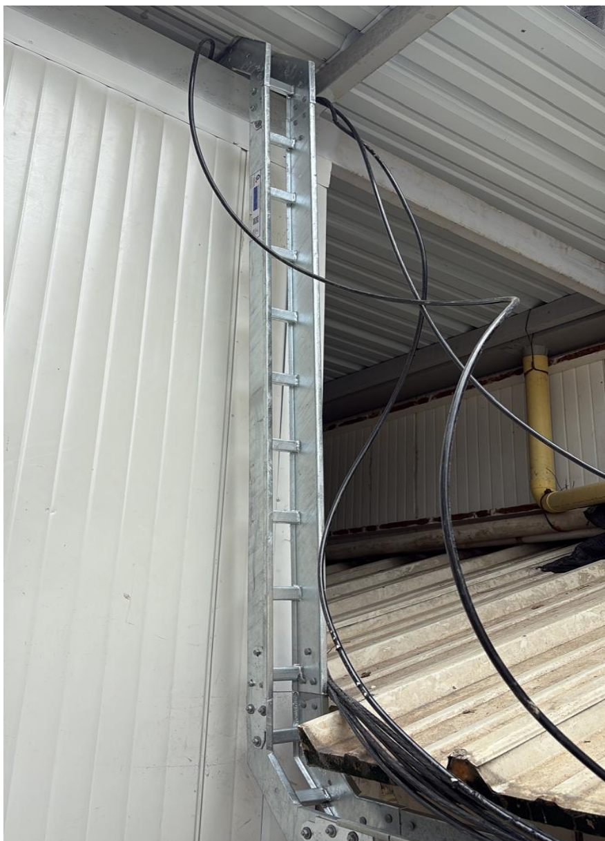
Figura 14 armado de bandejas porta cables acometida.
