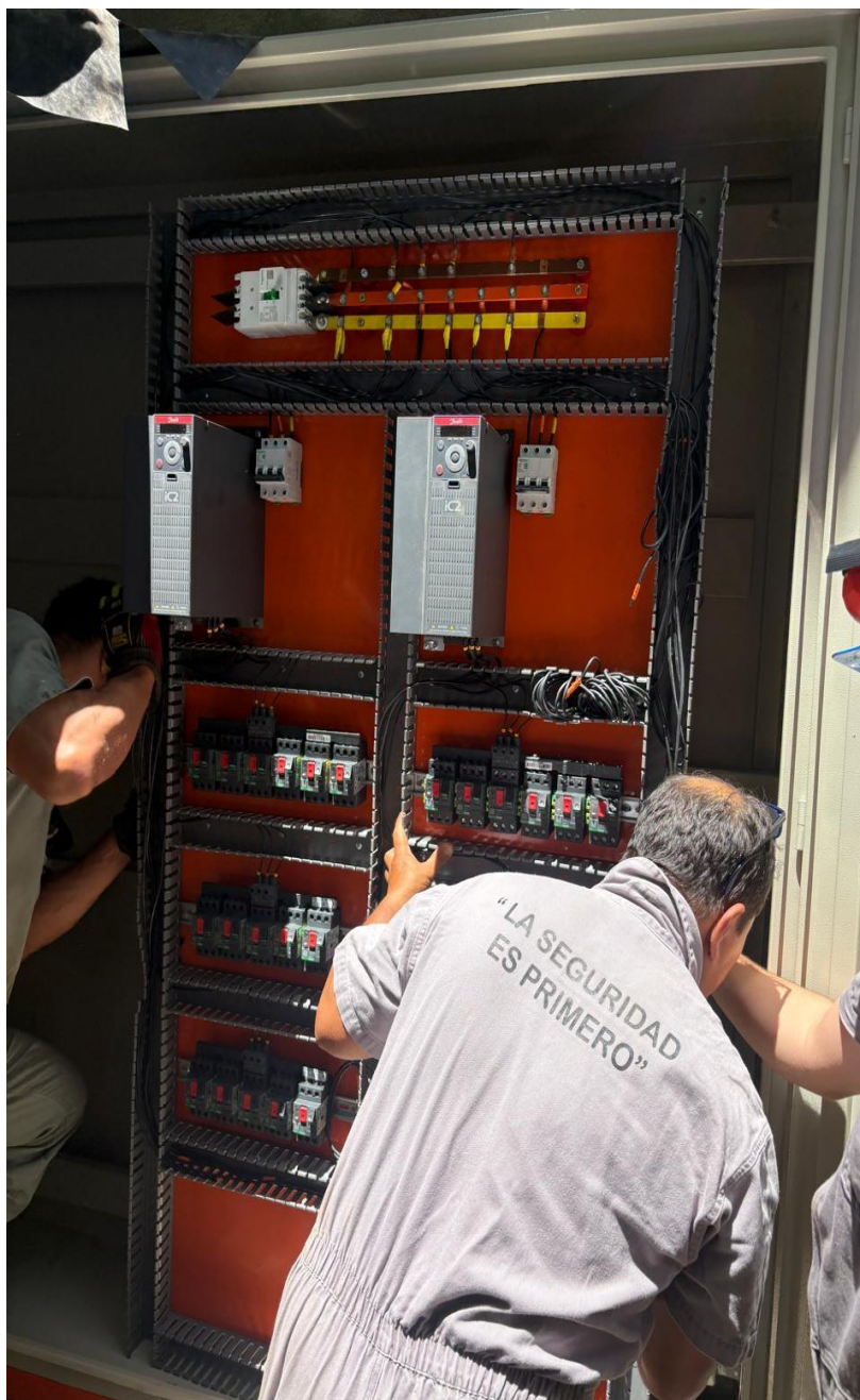
Figura 27 Montaje de tablero.
