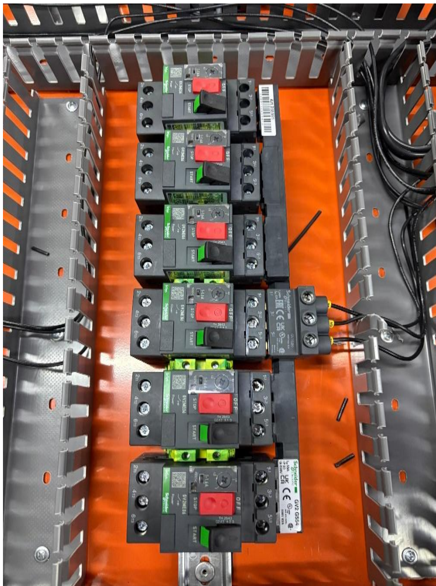
Figura 24 Instalación de los guardamotores en el tablero eléctrico.
