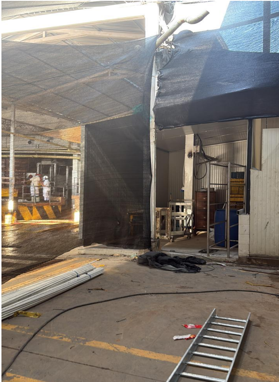
Figura 15 Armado de Bandeja porta cables ventiladores.
