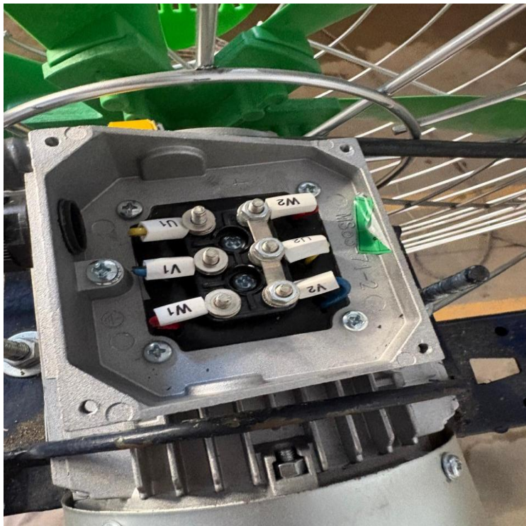
Figura 20 Conexión de motores.
