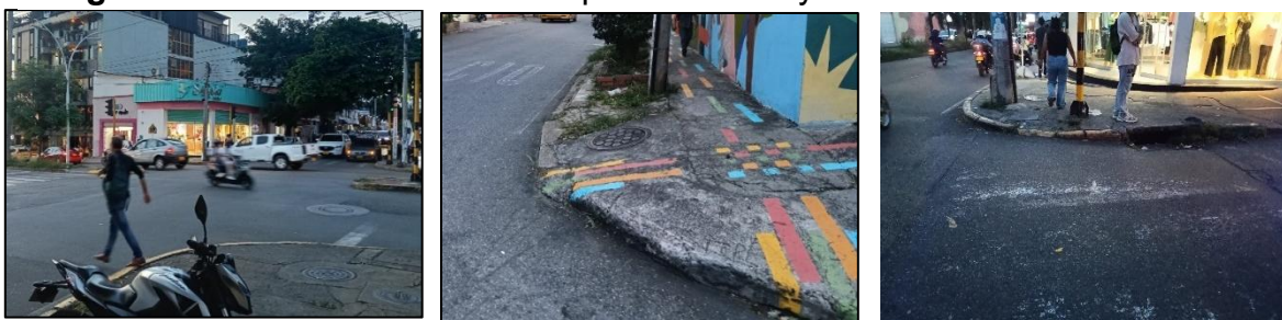
Figura 4. Falta de infraestructura peatonal incluyente.
