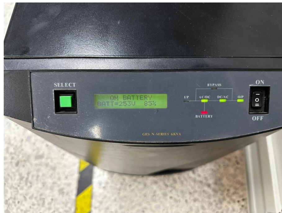
Imagen 77. Indicadores LED del panel frontal de la UPS (Autores, 2025)
