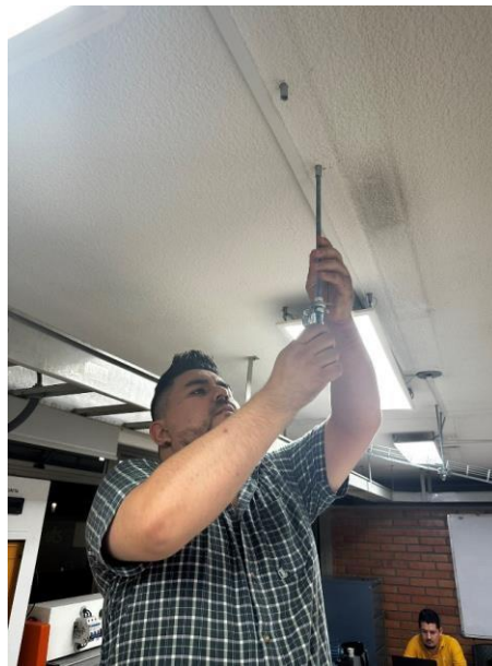
Imagen 84. Instalación de anclajes de expansión para varilla roscada. (Autores, 2025)
