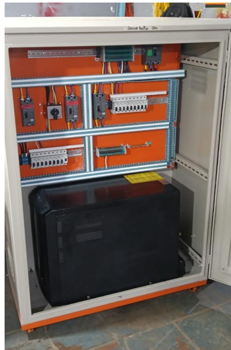
Imagen 90. Disposición final interna del tablero de UPS y previa instalación del UPS. (Autores, 2025)
