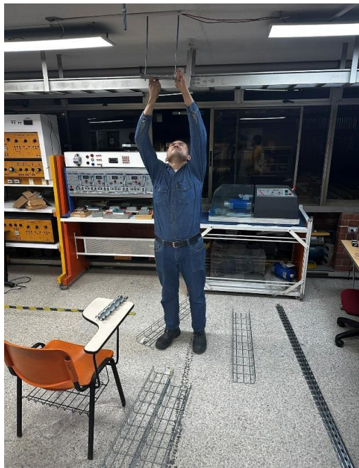
Imagen 85. Instalación de soportes peldaño dentado para bandeja porta cables tipo malla. (Autores, 2025)
