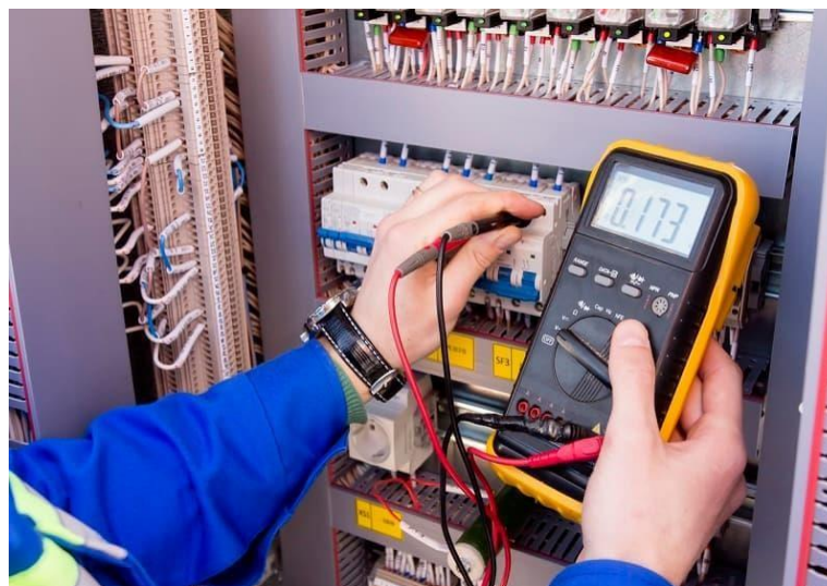
Imagen 54. Revisión de tensión a tablero eléctrico. (Suministro de Materiales Electricos JD LTDA, 2021)
