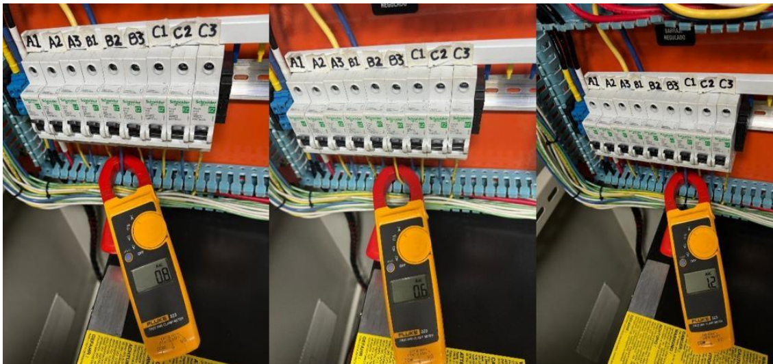
Imagen 112. Registro de corrientes en circuitos B1, B2 y B3 en modo batería. (Autores, 2025)
