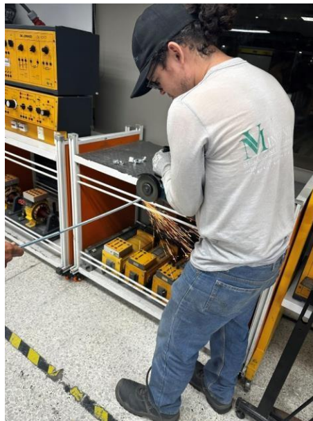
Imagen 83. Cortado de varilla roscada para soportes de la bandeja tipo malla. (Autores, 2025)
