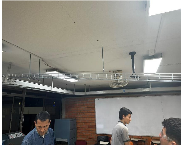
Imagen 86. Instalación de bandeja porta cables tipo malla. (Autores, 2025)
