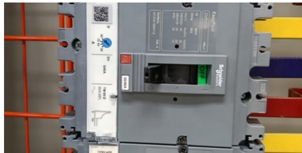
Imagen 62. Selección del totalizador principal para protección del tablero UPS. (Autores, 2025)
