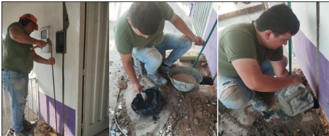
Figura 16. Acondicionamiento del sistema de puesta a tierra
