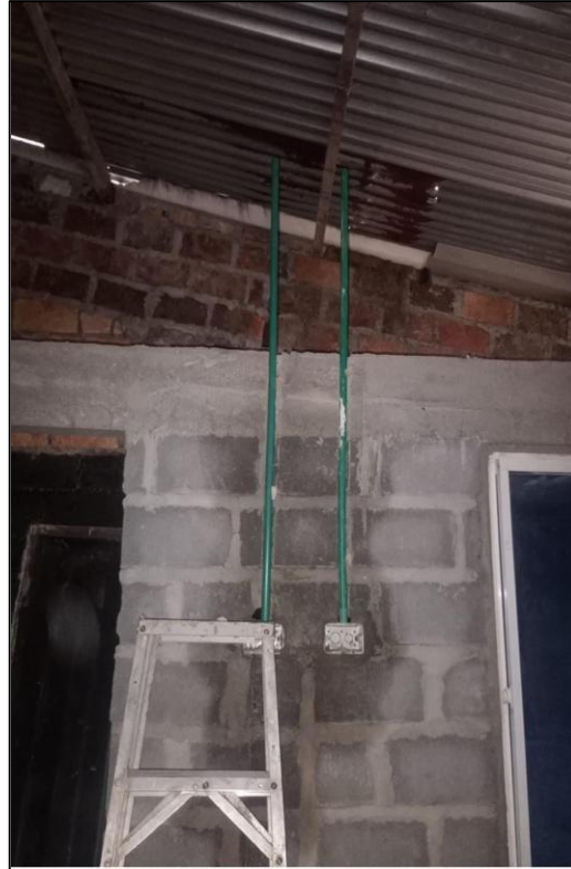
Figura 26. Tubería aérea entre cocina y sala
