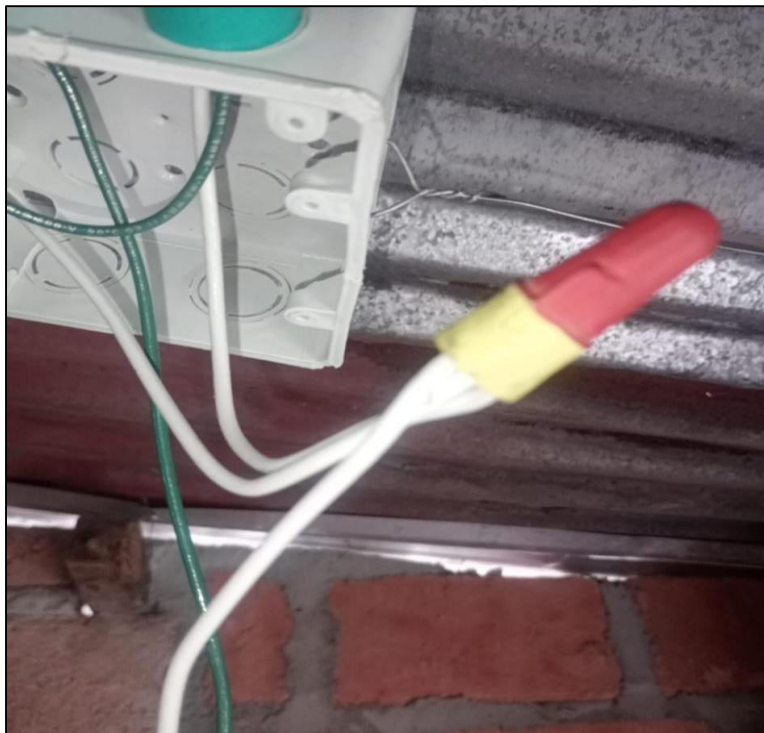
Figura 31. Empalmes con conector tipo capuchón
