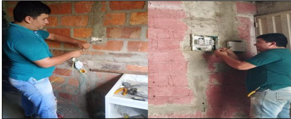
Figura 32. Instalación de conductores y protecciones eléctricas
