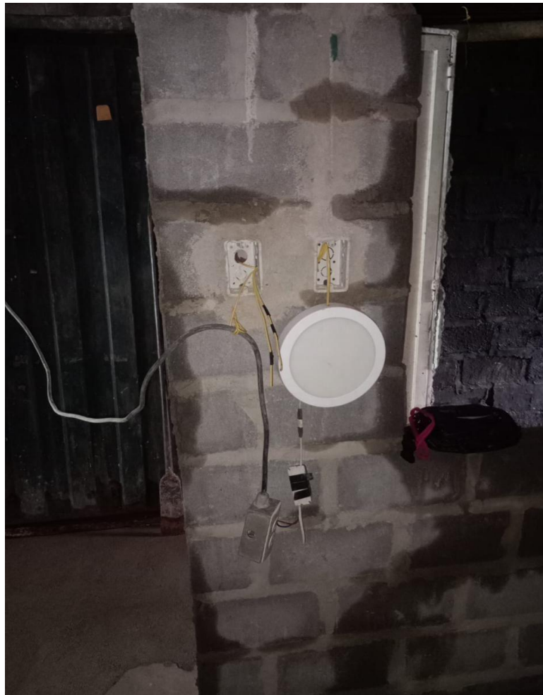
Figura 38. Plafón LED y tomacorriente instalados
