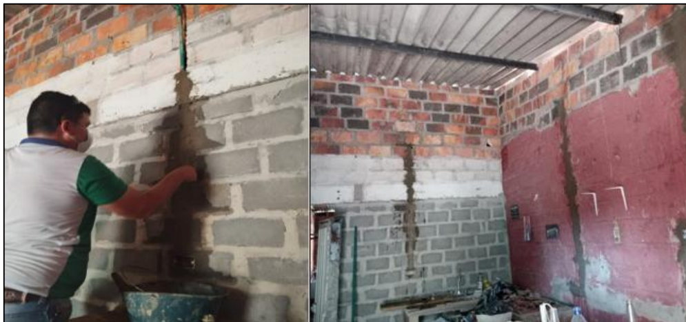
Figura 23. Regatas en pared para canalización empotrada
