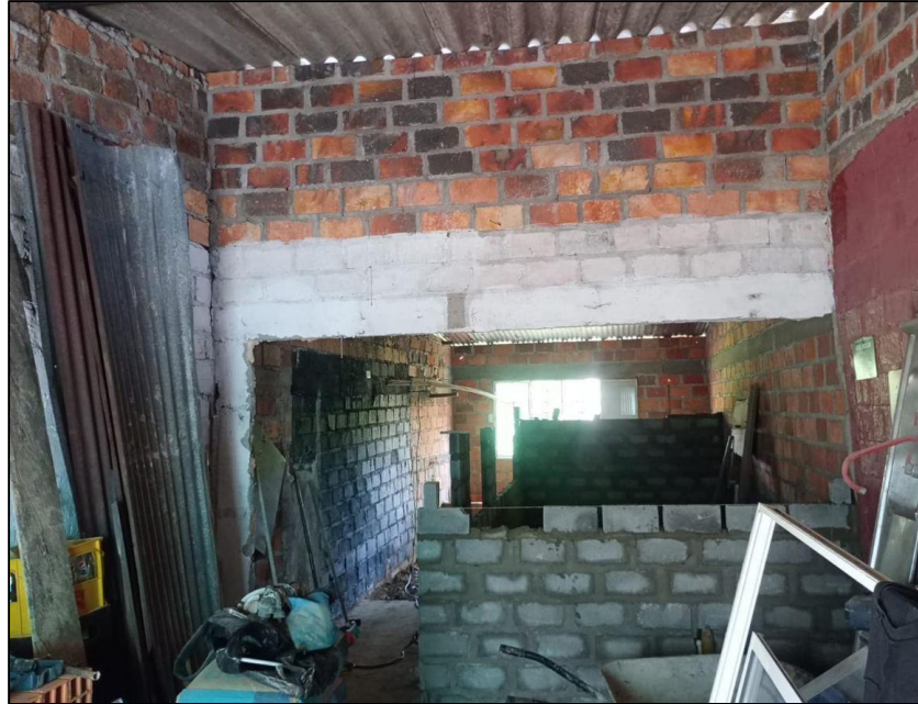
Figura 4. Estado inicial de la vivienda - vista interior
