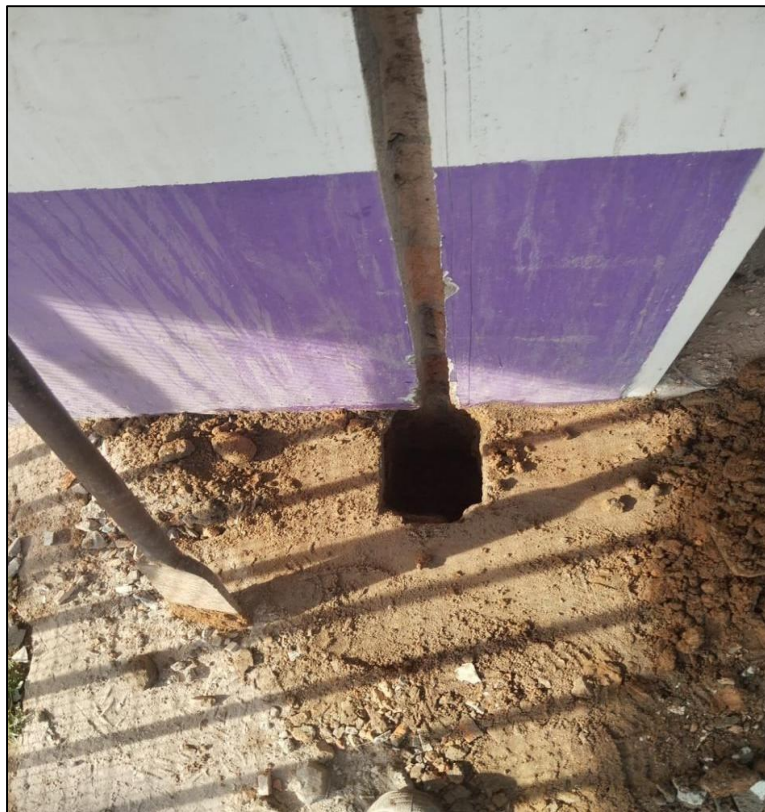
Figura 15. Excavación e hincado de varilla de puesta a tierra
