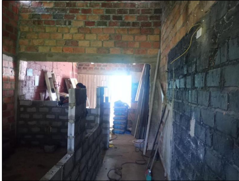
Figura 5. Estado inicial - pasillo y áreas internas
