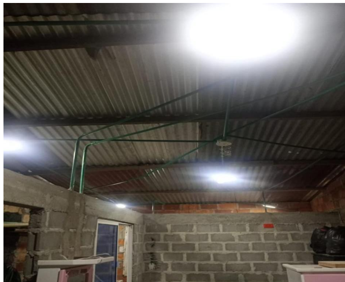
Figura 39. Verificación del sistema de iluminación
