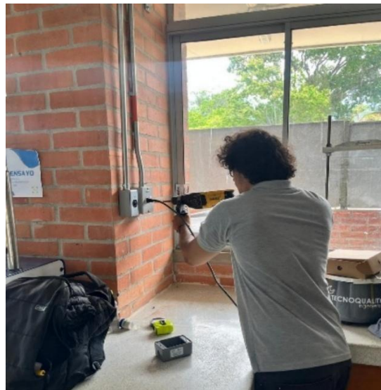
Ilustración 18. Adecuación para instalación de cajas metálicas para puntos de red
