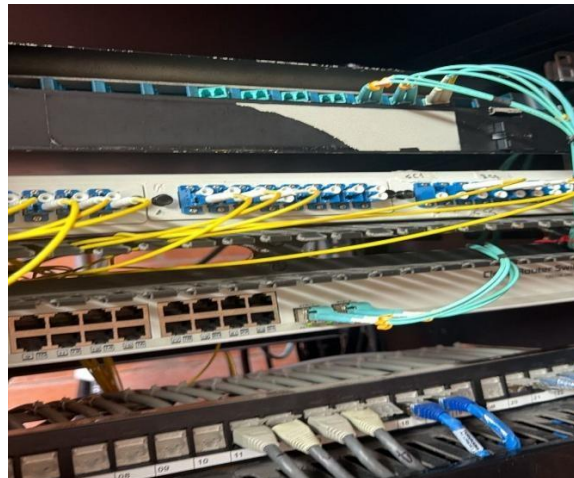
Ilustración 8. Entrega canal de fibra óptica data center
