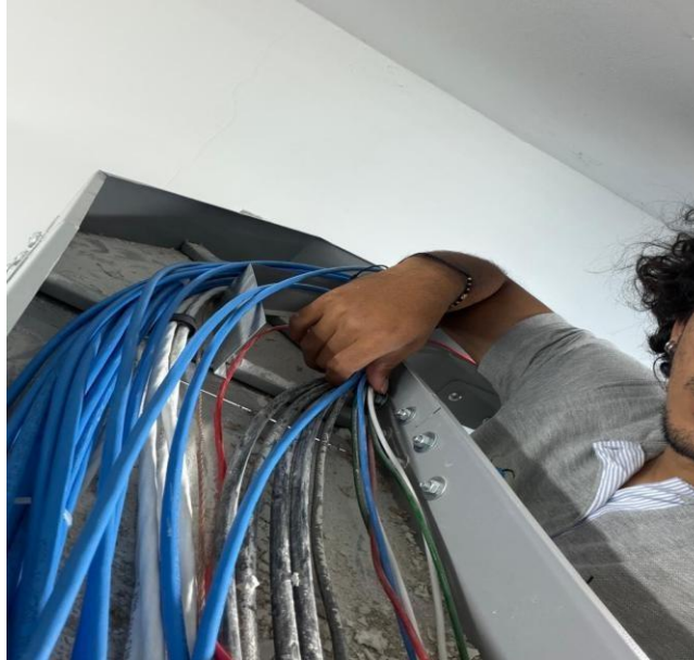
Ilustración 23. Proceso de peinado de cable UTP
