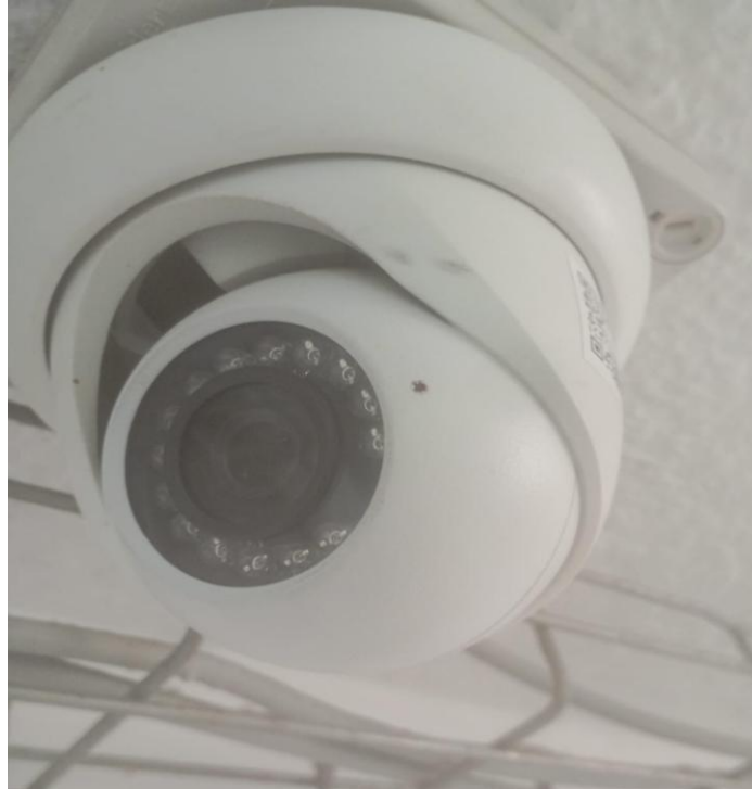
Ilustración 15. Instalación y montaje de dispositivo de videovigilancia tipo domo
