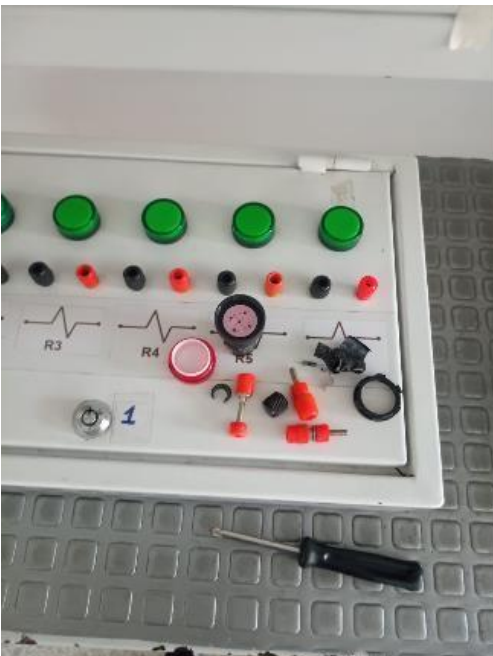
Figura 2 Cambio de pilotos a banco de resistencias banco de trabajo Fuente: autor
