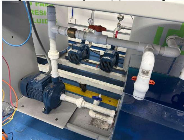
Figura 21. Desmontaje del equipamiento original
