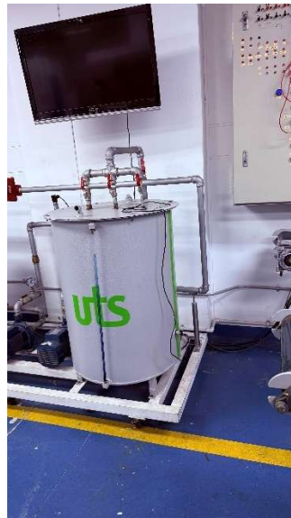
Figura 10. Cableado de sensores capacitivos
