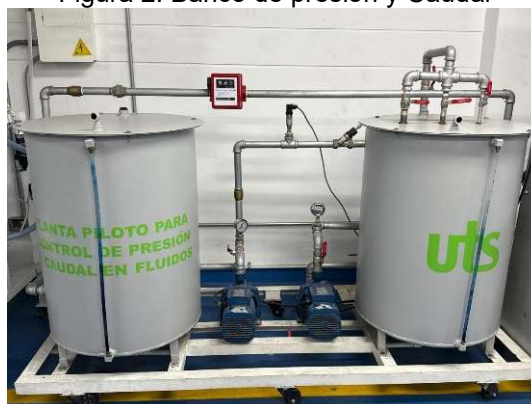
Figura 2. Banco de presión y Caudal
