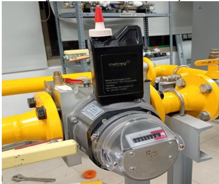
Figura 29. Lubricación del medidor de flujo
