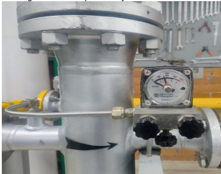
Figura 3. Filtro de partículas y manómetro diferencial
