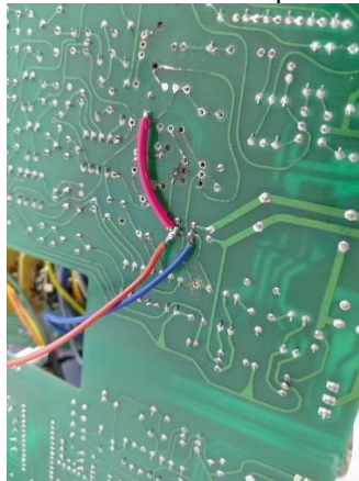
Figura 40. cables de conexión de potencia resoldados
