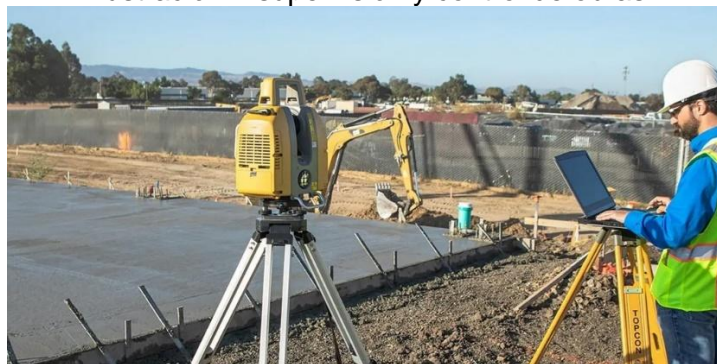
Ilustración 7 supervisión y control de obras
