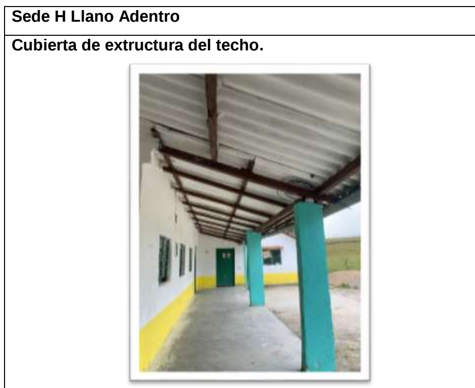
Figura 6: Inspección de la infraestructura en general
