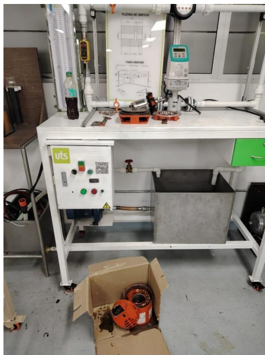
Imagen 7. Mantenimiento electrobomba del módulo de pérdidas en tubería
