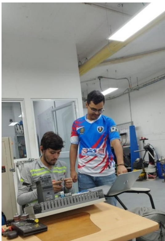
Imagen 17. Apoyo en el diseño y montaje eléctrico del nuevo módulo
