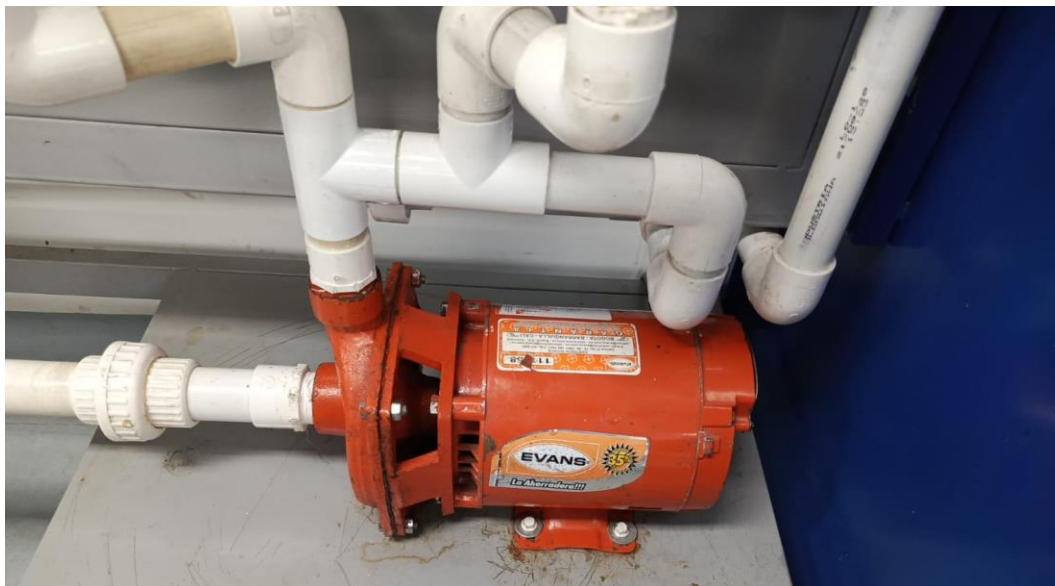
Imagen 11. Armado y Montaje de la Electrobomba
