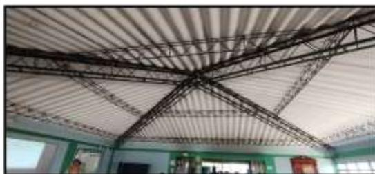
Durante la inspección ocular la infraestructura metálica del techo se ve con leves signos de perdida de pintura, esto conlleva a la presencia de corrosión. Es importante garantizar el estado de la estructura para su buen funcionamiento, con la inspección de personal capacitado que garantice el estado de la estructura en toda la institución
