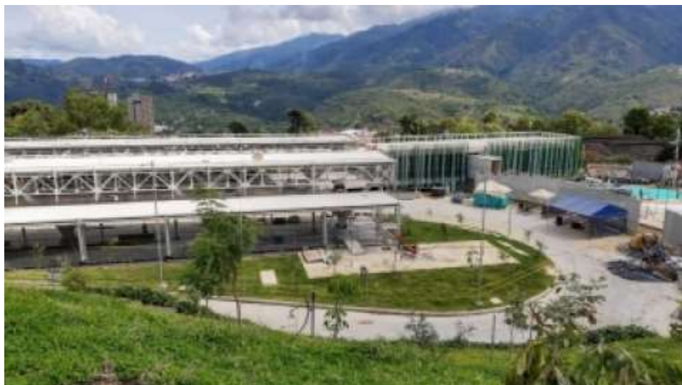
Figura 2 Portal Norte Bucaramanga
