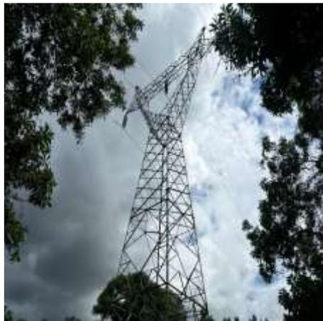
Torre constituida en metal con brazos en forma de "V" invertida. Diseñada para doble circuito trifásico, visible por los seis aisladores de suspensión tres a cada lado, compuesta por una altura estimada entre 35 y 50 metros
