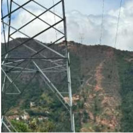
Se observó una torre de transmisión de alta tensión, compuesta por perfiles de acero galvanizado dispuestos en forma de rejilla. lo que indica una línea de transmisión a lo largo de una servidumbre eléctrica en zona montañosa.
