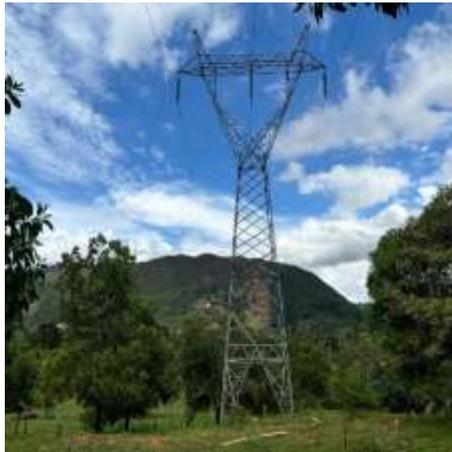
se observó una torre de alta tensión compuesta por 6 cables principales 3 por cada lado, lo que indica un sistema doble circuito trifásico, común para líneas de 115 kV, 220 kV o 500 kV.
