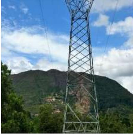
Se observan tres fases de líneas de alta tensión y posiblemente un cable de guarda en la parte superior, la cual es una línea trifásica de transmisión entre cables tensados entre torres indicando continuidad en las líneas.
