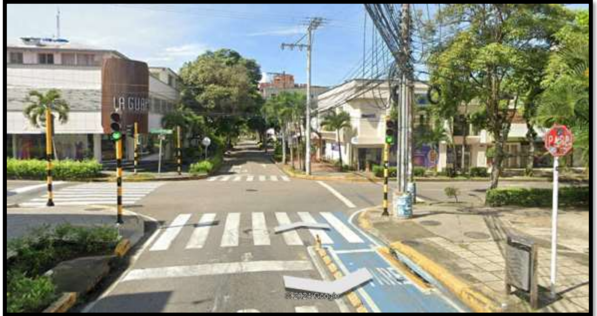
Ilustración 18. Punto crítico, fuente Google Earth.
