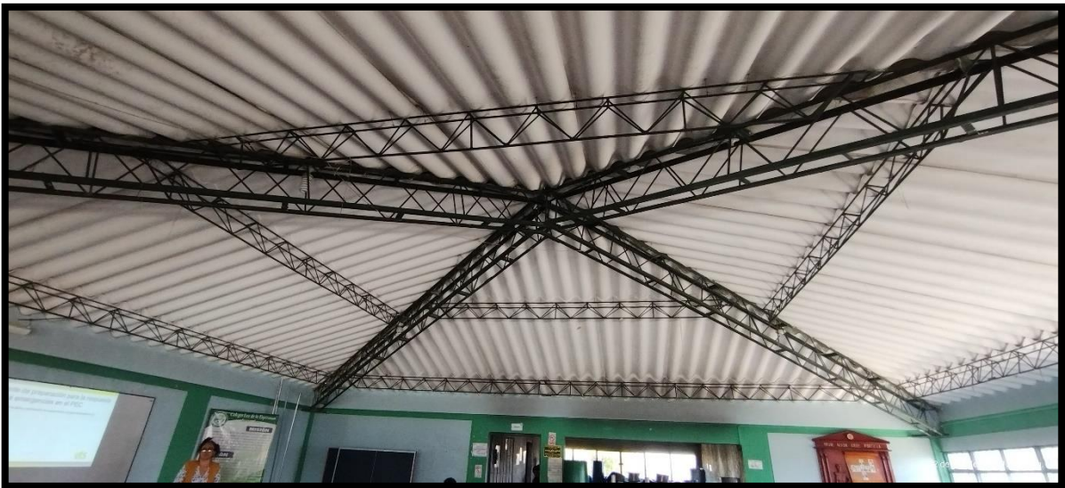
Figura 11. Estructura de cubierta.
