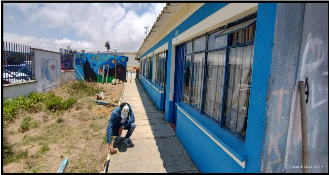
Figura 7. Equipo utilizado y personal capacitado.
