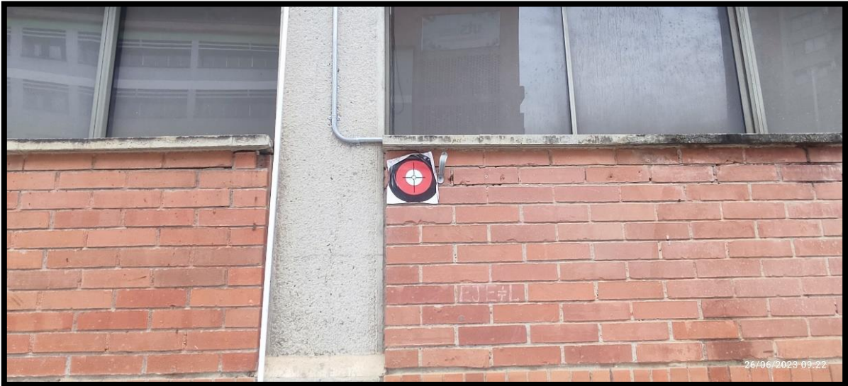
Figura 9 Vértice principal 01 materializado al costado oriental edificio Tekné
