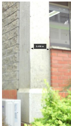
Figura 45 Medición de columna
