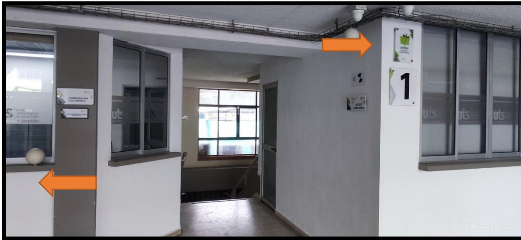
Figura 15 Esferas de referencia instaladas.
