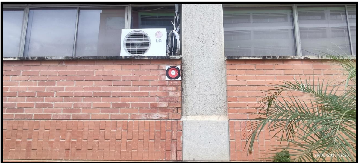
Figura 10 Vértice principal 02 materializado al costado occidental edificio Tekné
