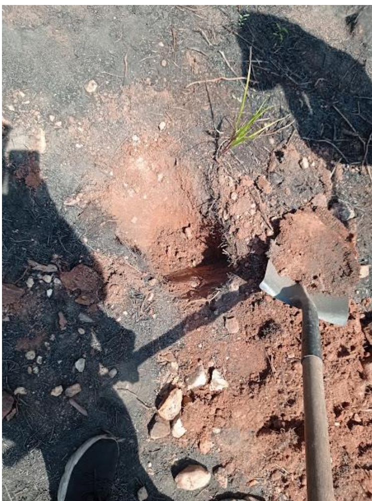
Figura 5. Remoción de cobertura vegetal y corte en V.
