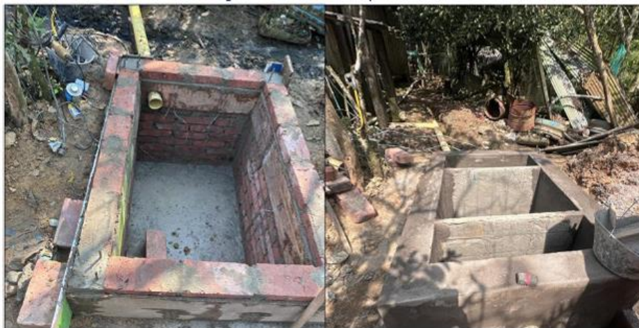
Figura 10. Construcción de la trampa de grasas
