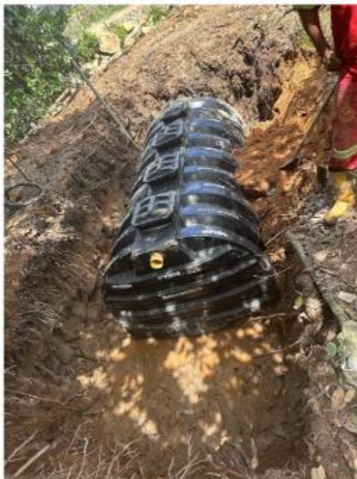
Figura 11. Instalación del sistema séptico integral
