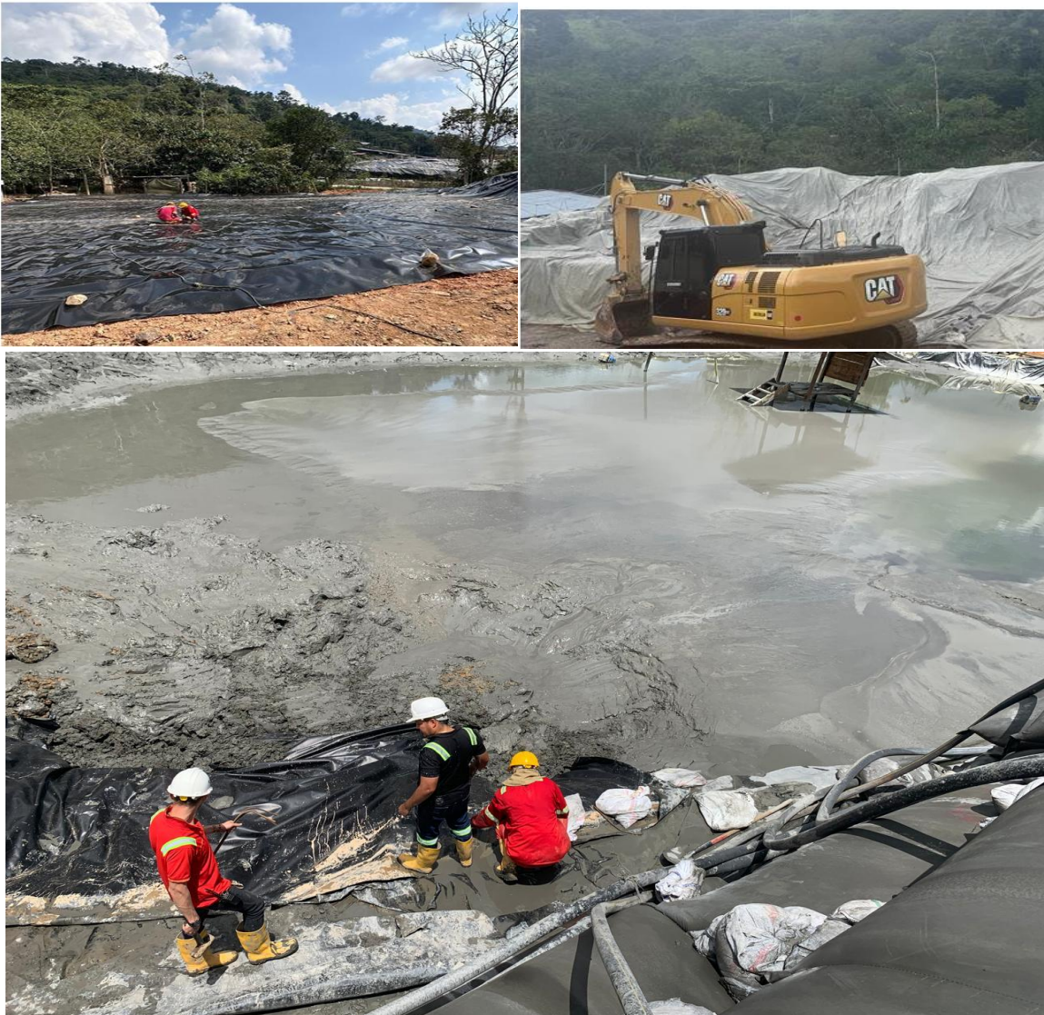
Figura 15. Adecuación del patio de acopio y cubierta de relaves secos
