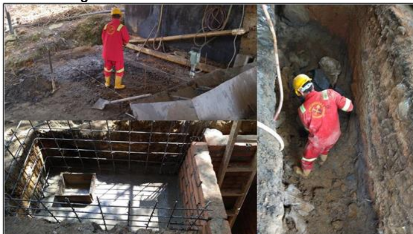
Figura 20. Construcción de la zona de lavadero
