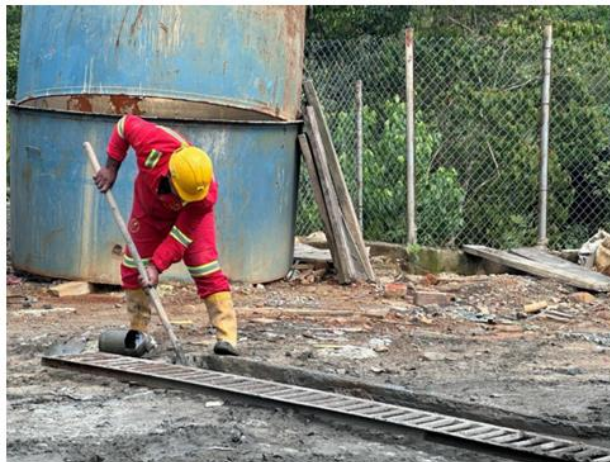
Figura 18. Limpieza de Cunetas
