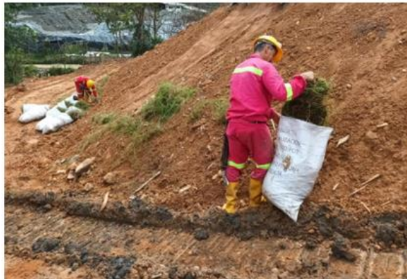
Figura 19. Proceso de revegetalización del talud
