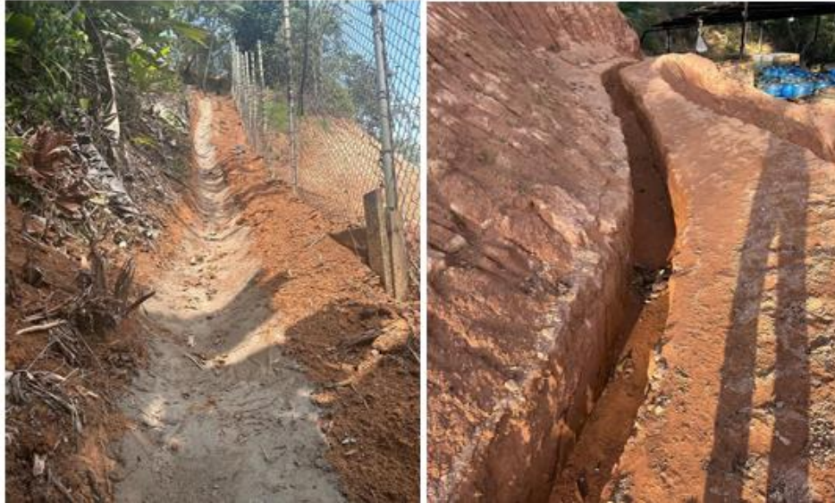
Figura 17. Cunetas y zanjas en talud de área priorizada
