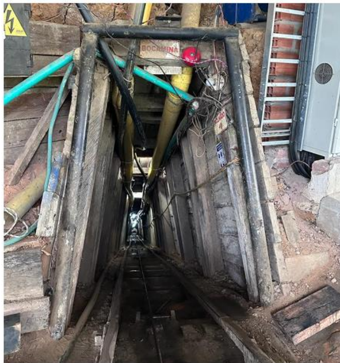
Figura 3. Zona de la bocamina
