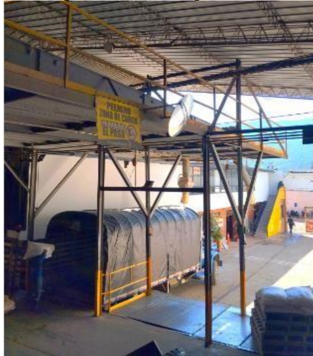
Figura 3. Muelles de cargue Planta 2.
