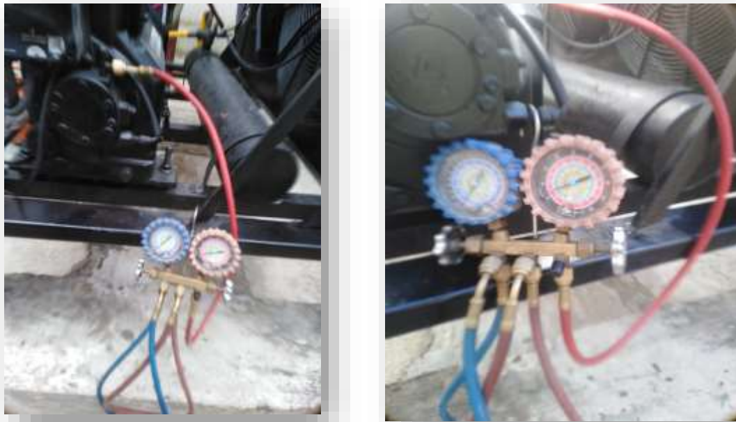
Figura 14. Conexión del Proceso de presurización del equipo
