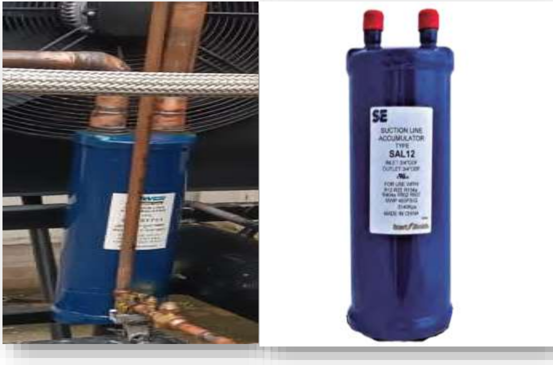
Figura 6. Acumulador de la línea de succión de baja presión
