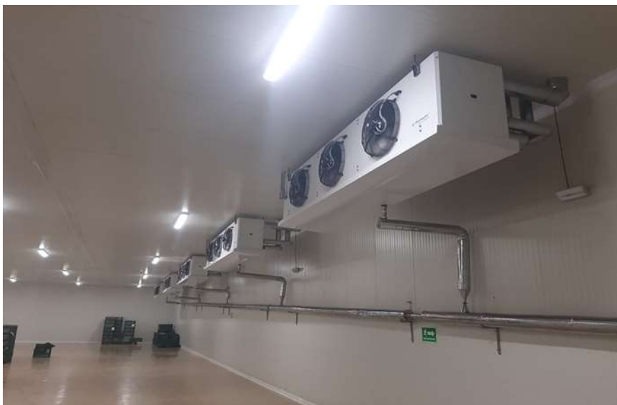
Figura 24. Evaporador de cuartos nuevos
