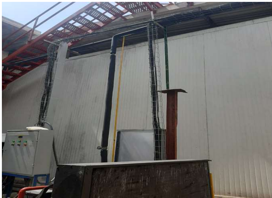
Figura 22. Rubatex de Rampas de Despacho Logística 1 y 2
