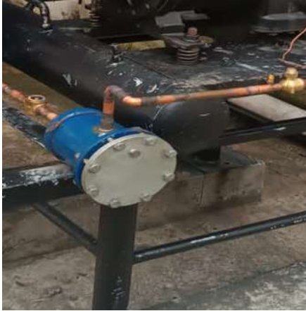
Figura 4. Filtro deshidratador de la línea de líquido stas-487t
