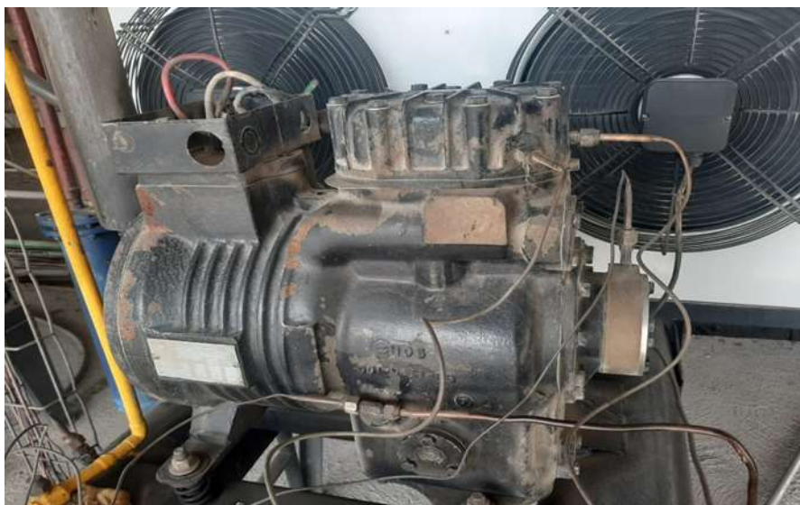
Figura 26. Compresor Coopeland 5 hp
