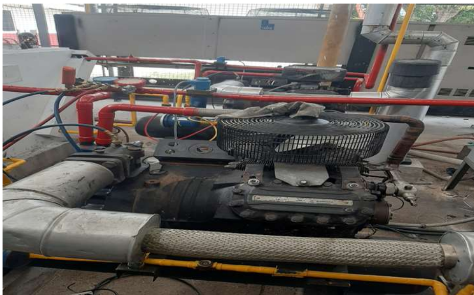
Figura 36. Motores choques térmicos 4.1 y 4.2
