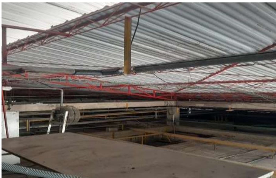
Figura 16. Tubería del cuarto 4
