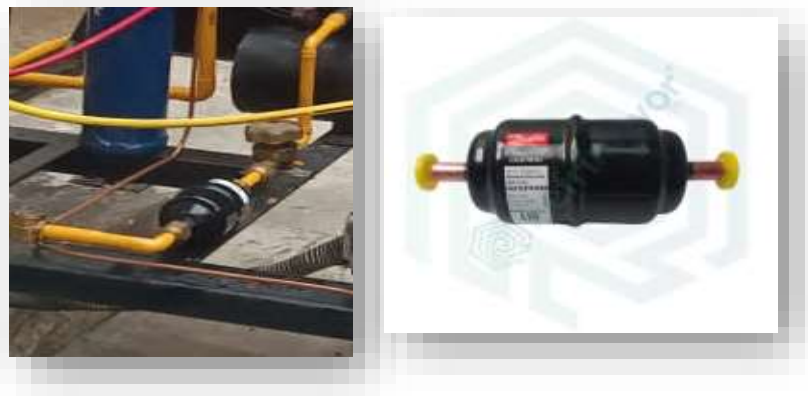
Figura 2.5. Filtro Secador hermético
