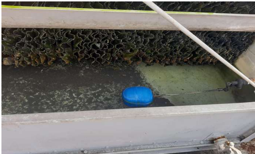
Figura 18. Ajuste del flotador torre 130
