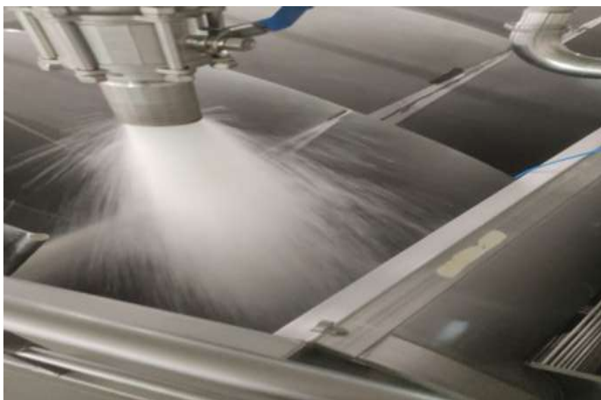
Figura 20. Comienzo del llenado del Chiller
