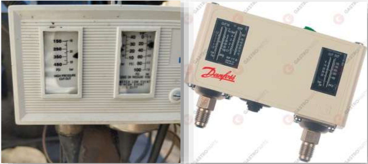
Figura 2.6. Presostato mecánico de alta presión
