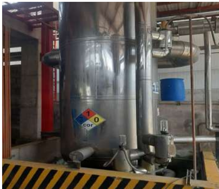
Figura 27. Recirculadora del IQF
